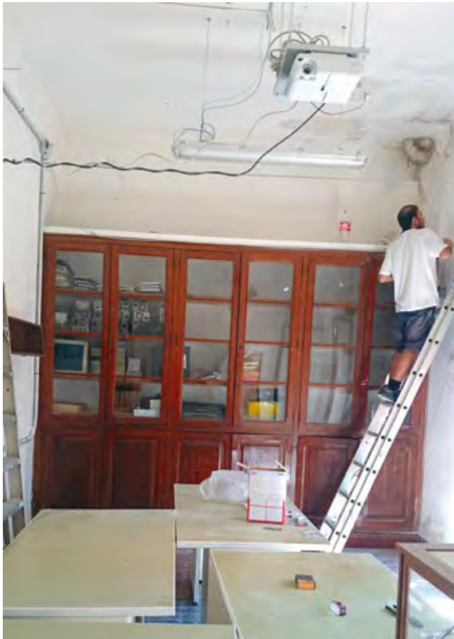
Un voluntario trabaja en reparar grietas en la que será la sala de ordenadores del Colegio Santiago Apóstol. Aportem aportó equipo informático, soporte y formación.
